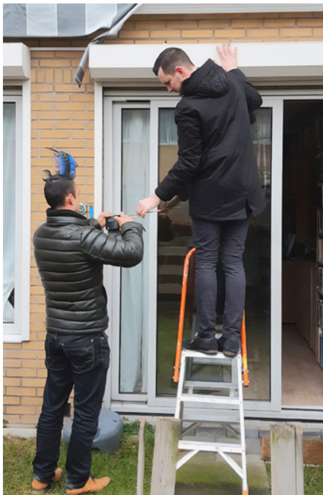
Buitendok: onderzoek van de spouwmuur
