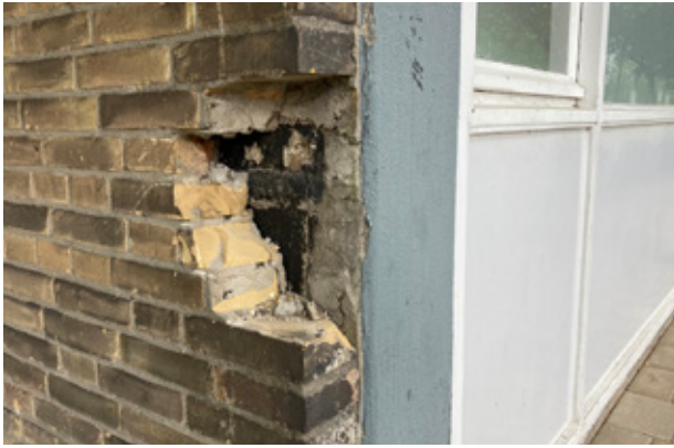
Deze muur bij Anslijn isoleren werd ruim tien keer zo duur
