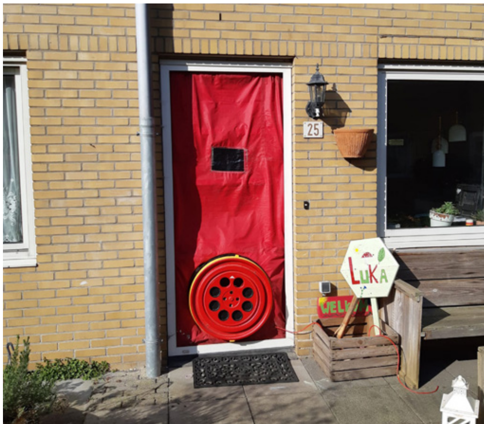
Onderzoek naar luchtdichtheid van de woning
