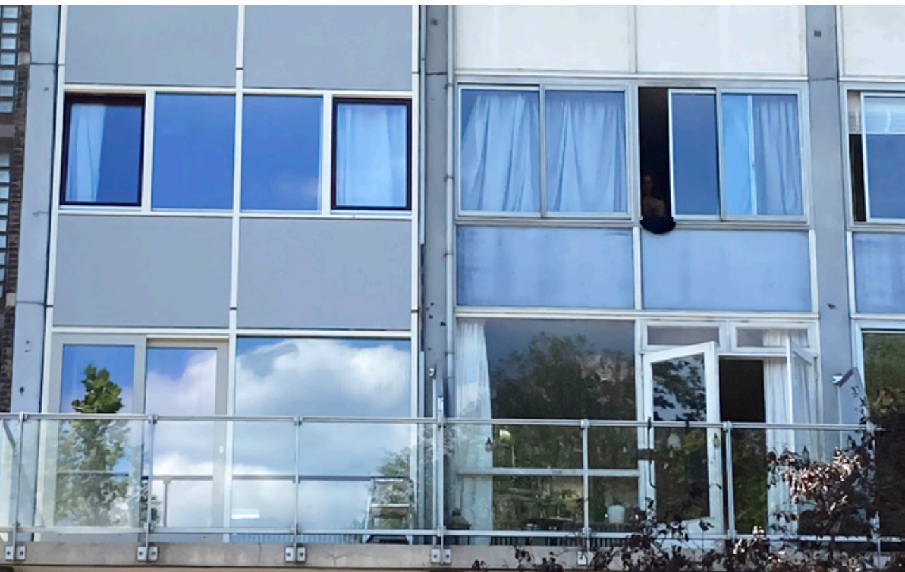
VvE Anslijn, zomer 2024: de eerste nieuwe kozijnen (links)
