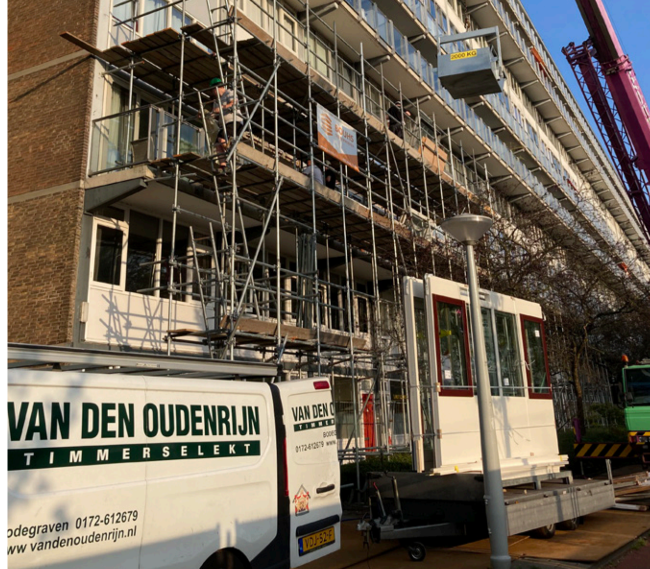
De renovatie bij Anslin is in volle gang
