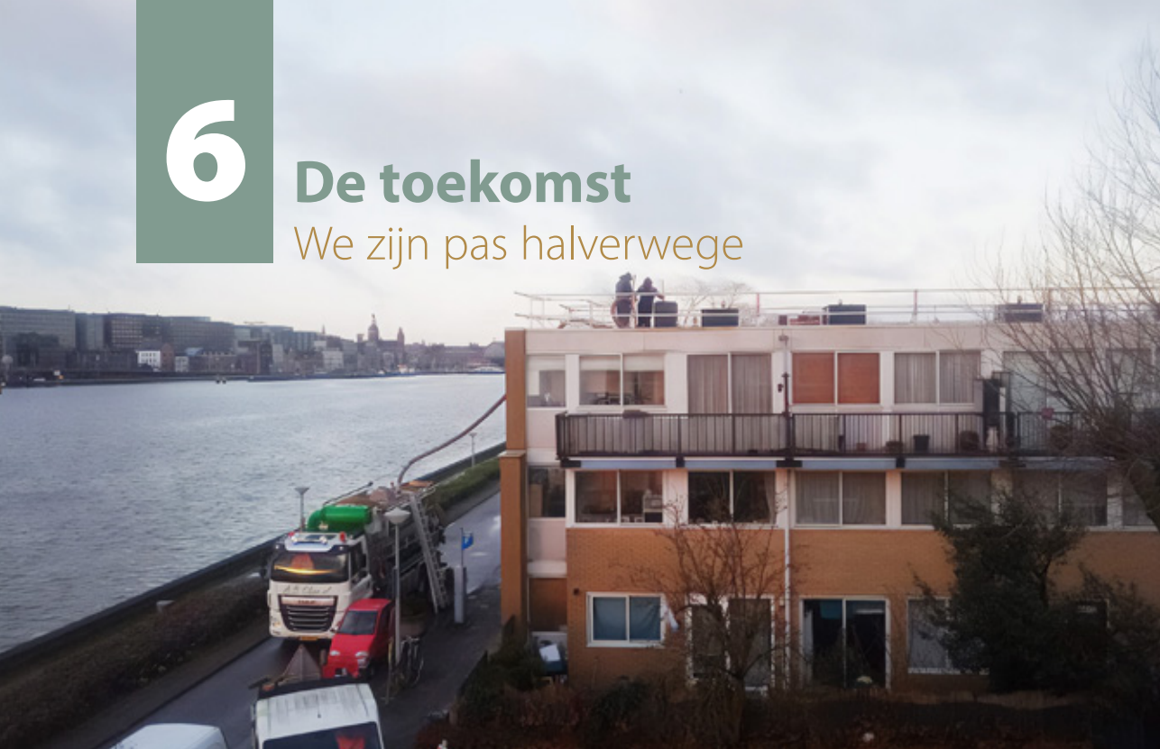
Buitendok, april: dakwerkers aan de slag, de renovatie is begonnen
