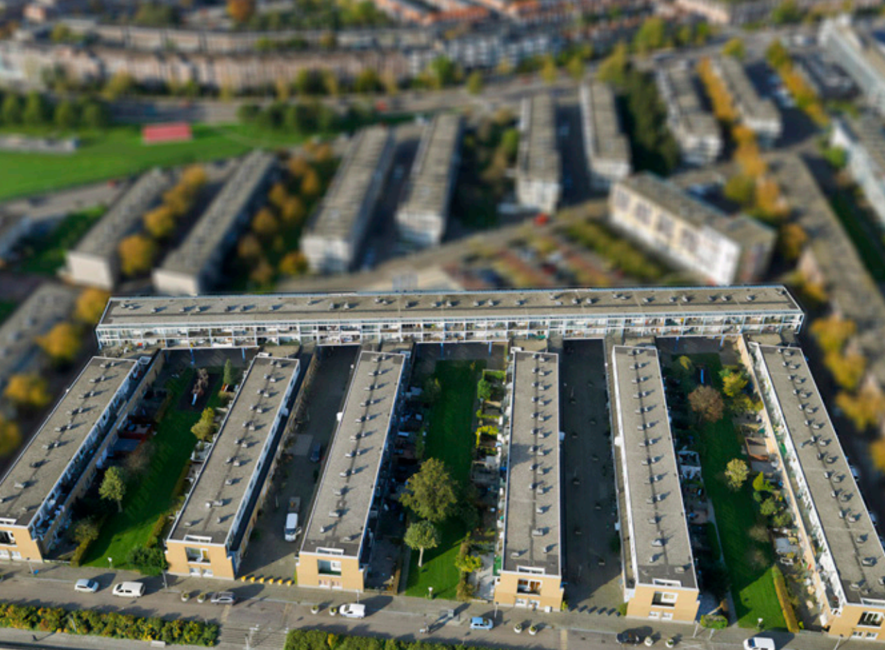
Buitendok op een recente luchtfoto. De weg op de voorgrond loopt langs de waterkant van het IJ.
